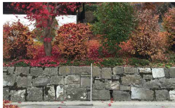
Abbildung 11: Natursteinmauer entlang der Winkelstrasse – ortstypisches Element.
