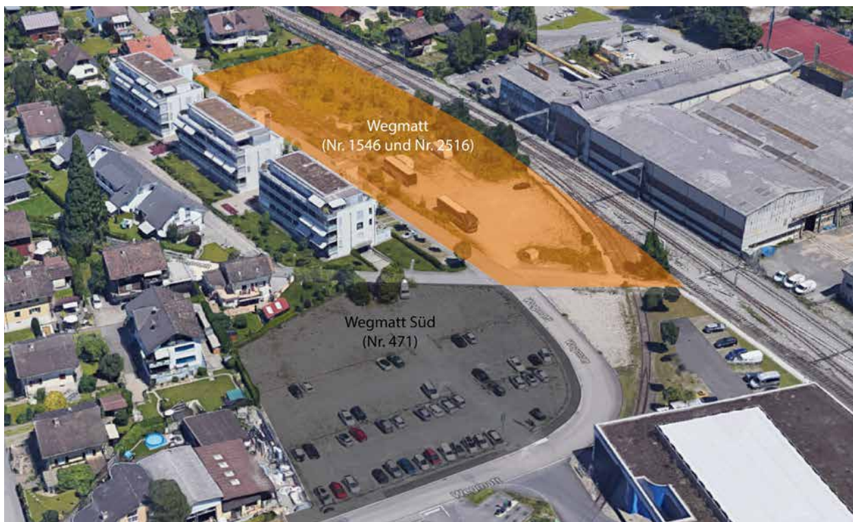
Abbildung 2: Luftaufnahme mit den eingezeichneten Grundstücken Nrn. 1546 und 2516 (Wegmatt) sowie dem Grundstück Nr. 471 (Wegmatt Süd). Quelle: Luftbild, Google Maps, https://www.google.ch/maps Abrufdatum 2017.
