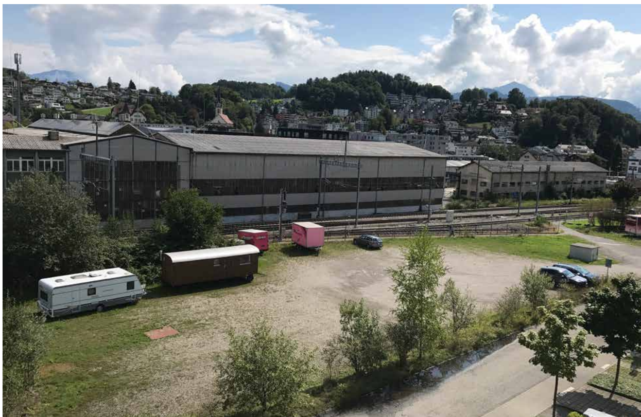
Abbildung 4: Heutige Situation der Wegmatt, Ansicht auf Grundstück Nr. 1546, Teil Süd (Foto F. Schnyder, Horw)
