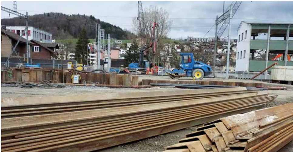
Jetzt kommen die Spuntwände definitiv zum Einsatz: Baustelle der Personenunterführung Wegmatt.
