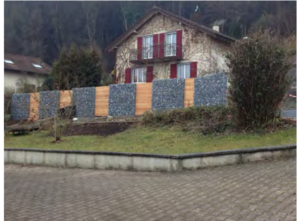
Gabione auf privater Fläche Quelle: SL-FP 2016
