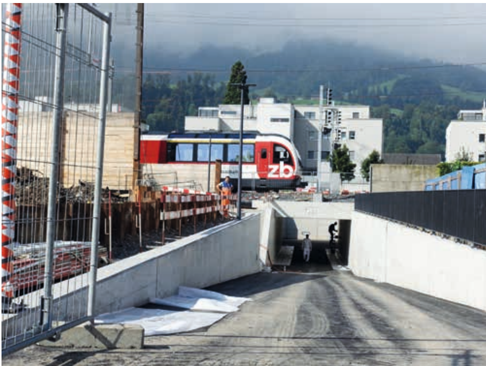
Die Unterführung Wegmatt kurz vor der Fertigstellung.
