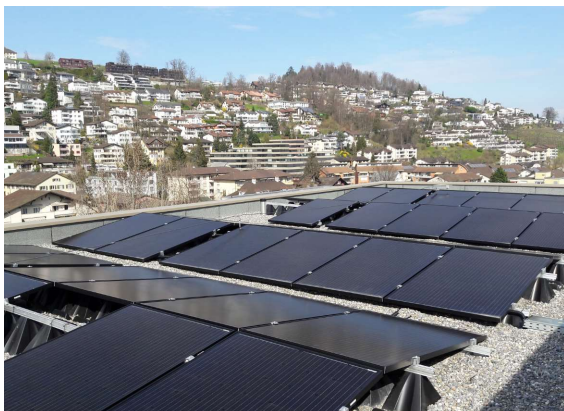
Flachdach, Module aufgebaut
