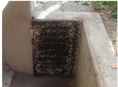
Einbau von Krallmatten
