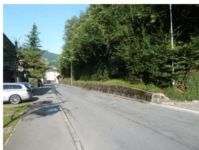
Winkelstrasse mit Stützmauer
