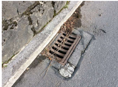
Sanierung von Schächten
