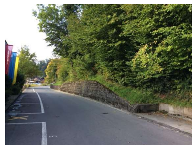
Stützmauer vis-à-vis Badi
