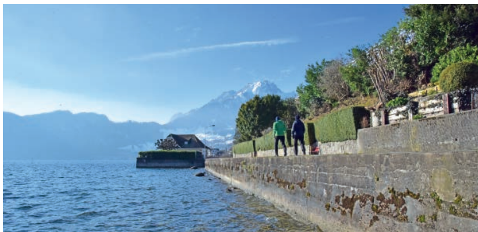
Zwei Spaziergänger schlendern der – schon bald sanierten – Ufermauer entlang.
