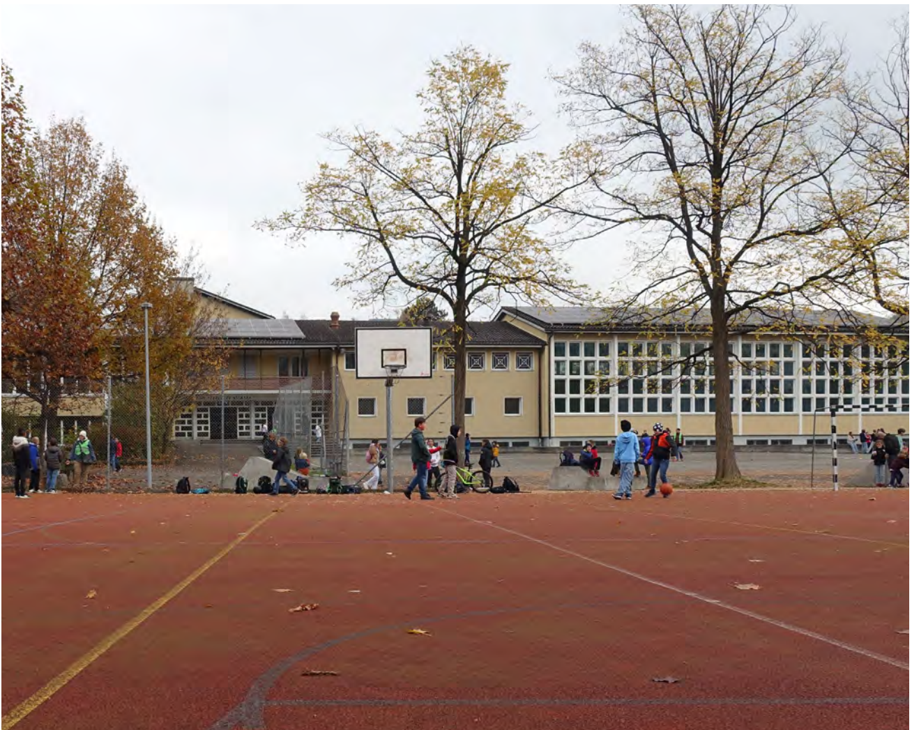
Zukünftiger Standort des Neubaus
