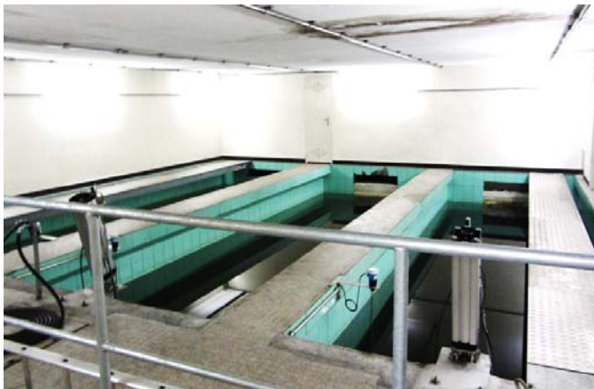
In diesen drei Becken befinden sich die erwähnten Zweischichtfilter.
