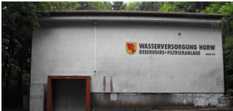
Das bestehende Gebäude der Aufbereitungsanlage Grämli.
