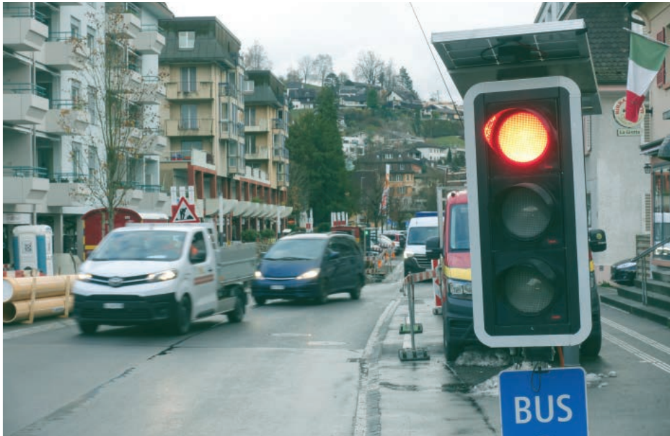
Noch ist hier eine Baustelle wegen der Erneuerung der Kanalisation. Doch ab Januar gibt es grünes Licht für die Umgestaltung der Kantonsstrasse.
