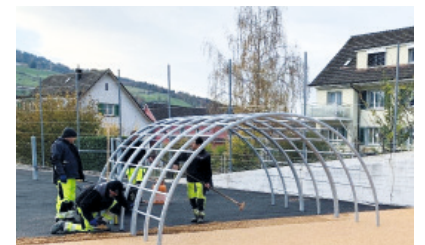
Belageinbau beim Spielplatzteil in Handarbeit.
