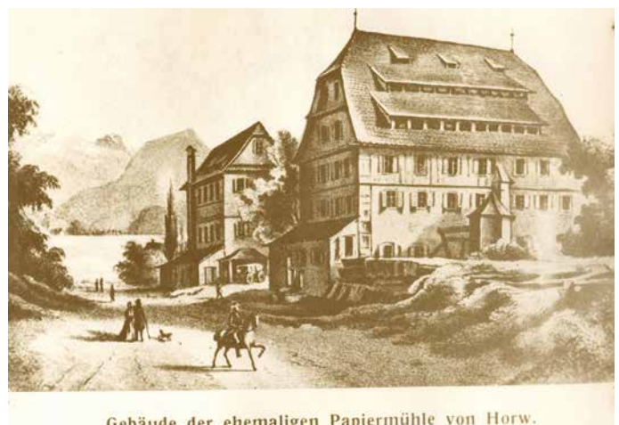
Gebäude der ehemaligen Papiermühle von Horw.
