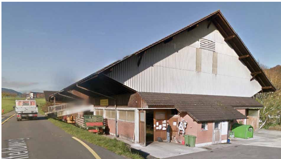
Die Betriebsscheune des Landwirtschaftsbetriebs Grämlis. Foto: Google maps
