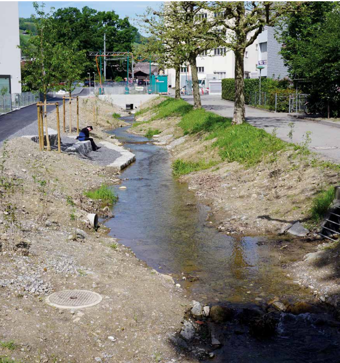
Der Ausbau und die Renaturierung des Steinibachs wurde erfolgreich abgeschlossen.
