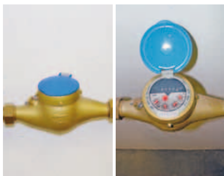
Installierter Wassermesser
