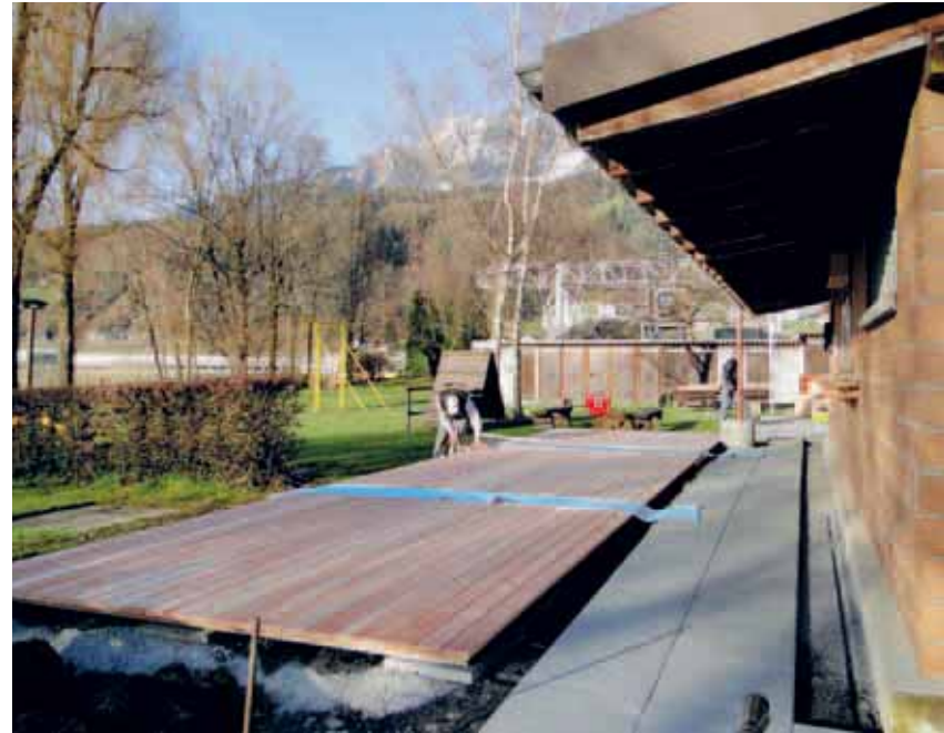
Seebad Horw: Arbeiter bei den letzten Handgriffen, damit auch die neue Holzterrasse ab 1. Mai benützt werden kann.
