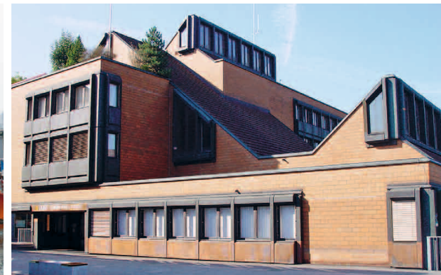
Das Gemeindehaus soll saniert werden.
