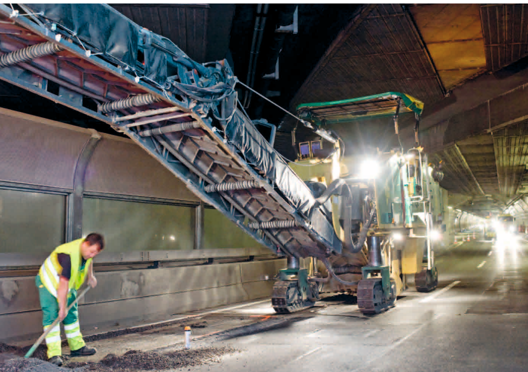
Eine Röhre des Sonnenbergtunnels ist nachts gesperrt, damit die Sanierungsarbeiten ausgeführt werden können. Der Reussporttunnel kann einstreifig befahren werden.
