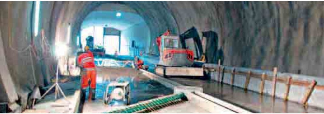
Im Hubelmatt-Tunnel läuft der Innenausbau auf Hochtouren.
