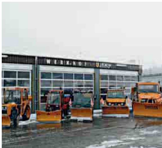
Beim Werkdienst muss die Heizung saniert werden.
