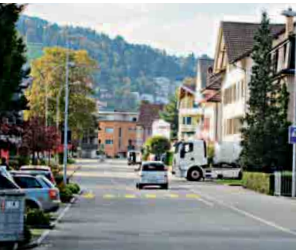
Krienserstrasse wird zur Quartierstrasse zurückgebaut.
