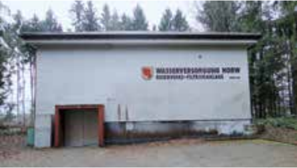
Die Trinkwasseraufbereitungsanlage Grämlis muss saniert werden.
