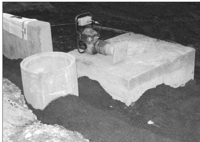
Leitungsbau vor der Seebadi.
