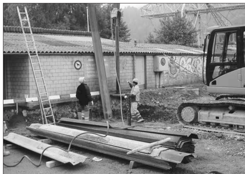
Neuer Bachübergang zwischen zukünftigem Parkplatz und dem Garderobengebäude.
