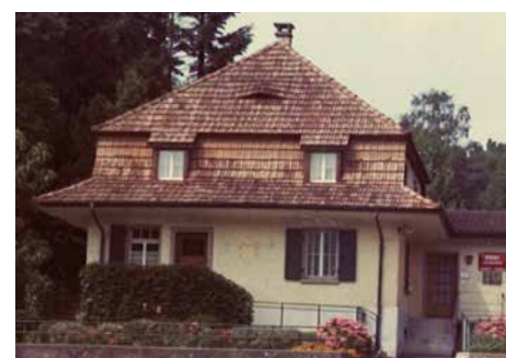
Das 1. Postgebäude in Kastanienbaum (1918 erbaut, oben) sowie später mit Anbau (1951).
