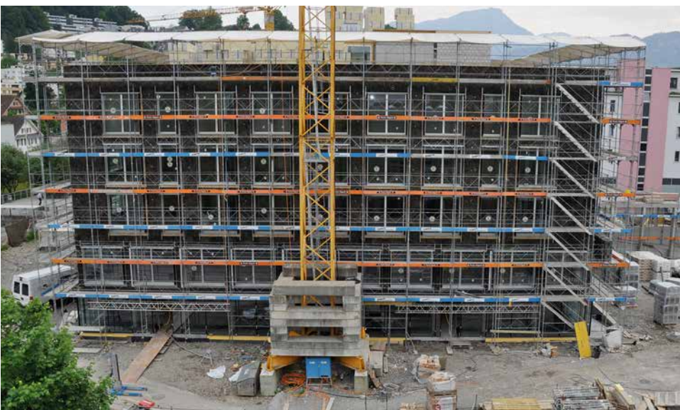
Wo früher der Musikschulpavillon stand, wird nun der neue «Kopfbau Ost» gebaut, wo neben Musikschulräumen auch die Bibliothek entsteht.
