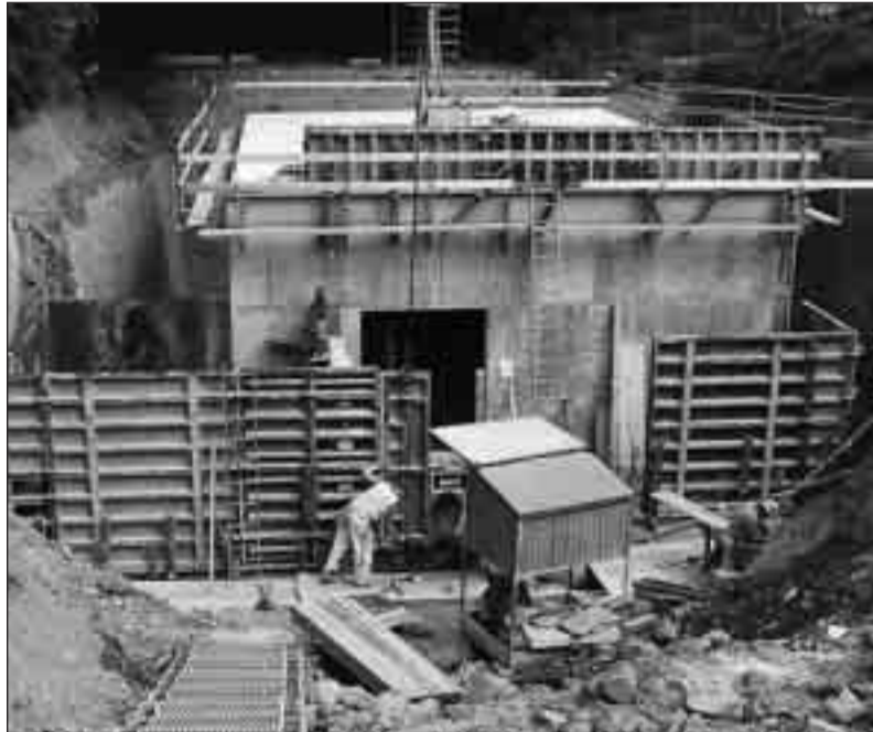
Abschluss Baumeisterarbeiten beim Pumpwerk Krämerstein. Trafostation und Eingangsbereich werden erstellt.
