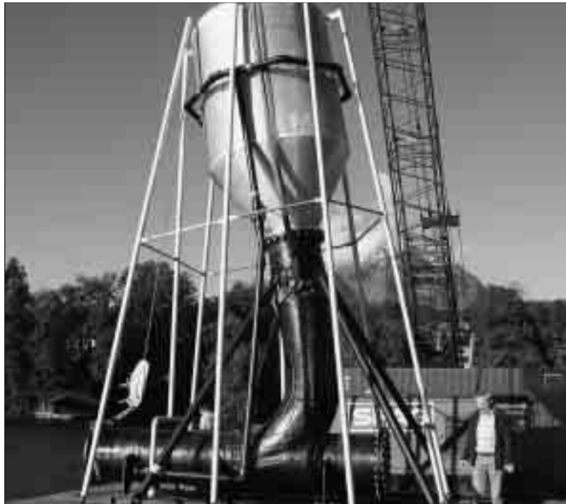
Der rund sieben Meter hohe Ansaugkorb kurz vor dem Einwassern ab dem Ponton.
