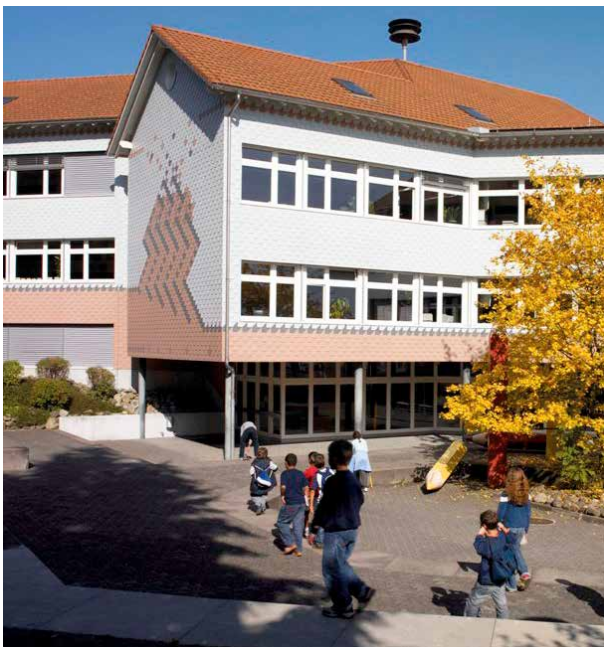
Das Schulhaus Spitz behält auch nach der Sanierung das äussere Aussehen, erfährt im Innenbereich jedoch räumliche Veränderungen. Foto: Priska Ketterer.
