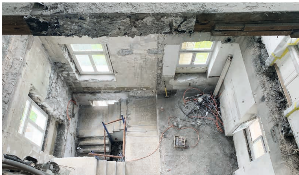
In der Villa Krämerstein wurde unter anderem das Treppenhaus Nord herausgenommen.
