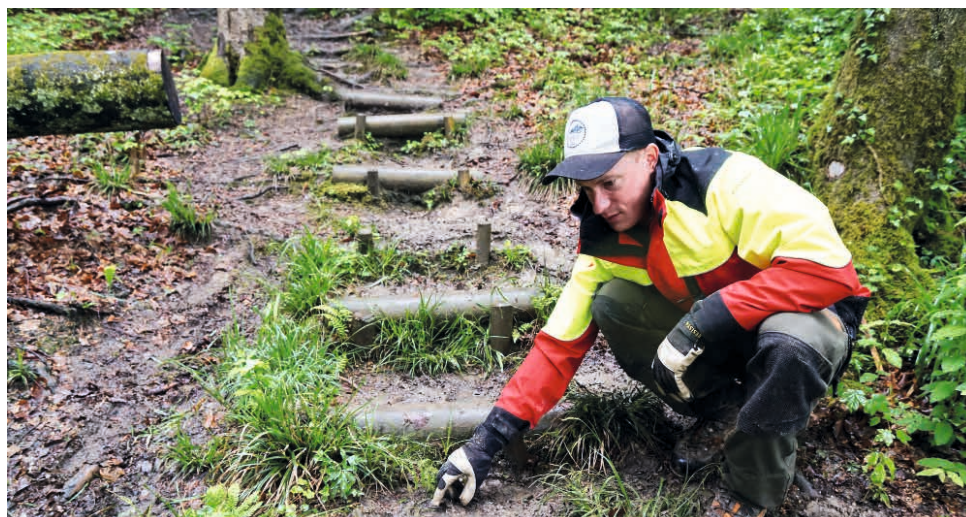
Projektleiter Adrian Wüest zeigt Stufen, die saniert werden müssen.
