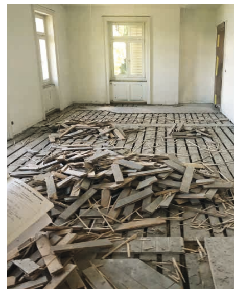
Der alte Boden wurde entfernt.
