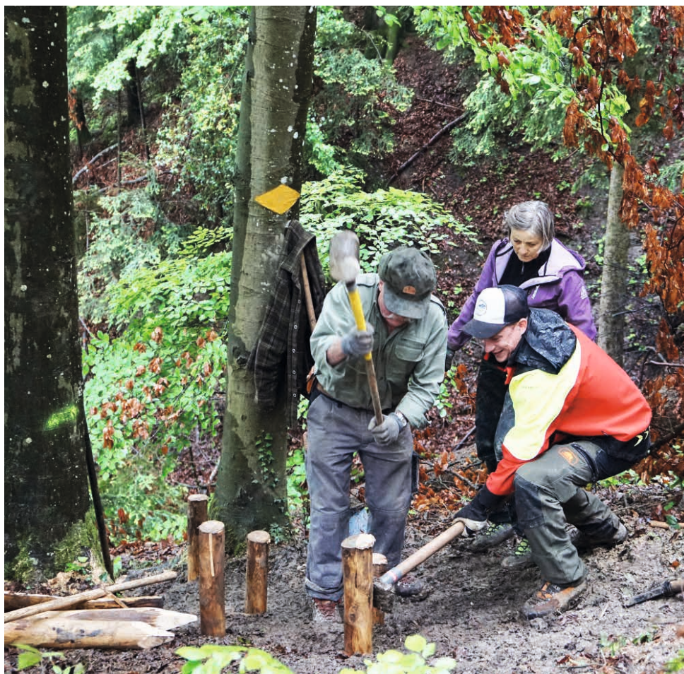
Im steilen Gelände schlägt der Bautruppf Pfähle für Treppenstufen ein.
