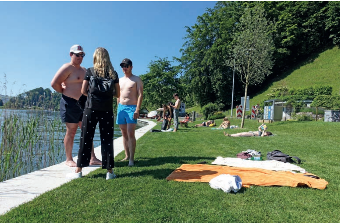
Die Wiese im Rüteli wird rege benutzt: Rechtzeitig auf die warme Jahreszeit hin sind die Bauarbeiten beendet.
