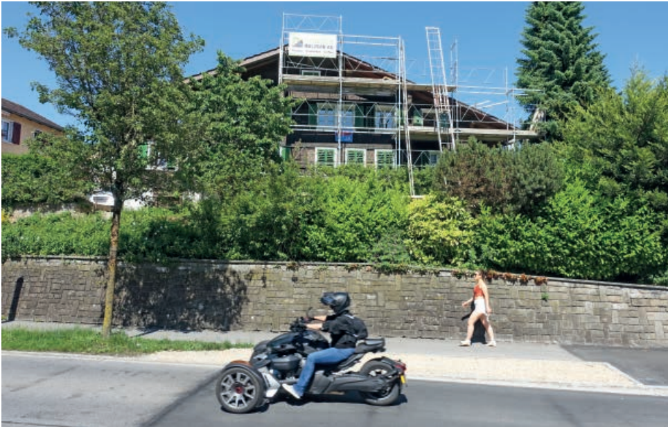
Das älteste Horwer Haus – hier im Bild mit dem eingerüsteten Hausteil Obmüli – thront über der Kantonsstrasse.
