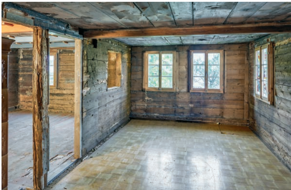
Die linke Wand dieses Raums im Erdgeschoss war die ehemalige Aussenwand aus dem Kernbau. Die restlichen Wände stammen aus dem 19. Jahrhundert. (Foto: Georg Sidler, Schwyz)
